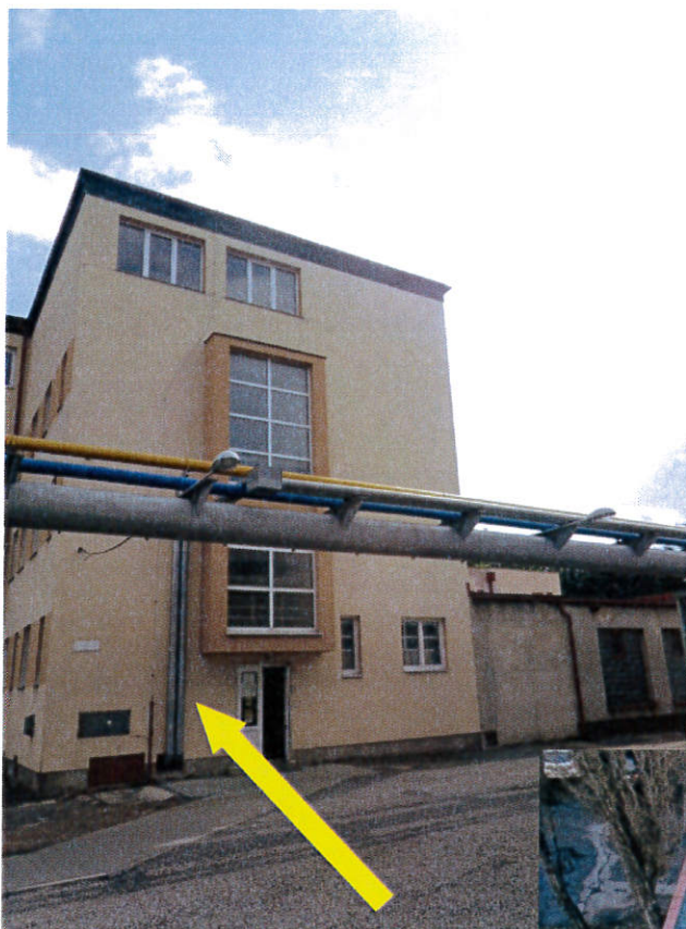
Západní fasáda objektu vč. části teplovodu (šipka), který bude odsazen dále od fasády (možnost osazení KZS)
